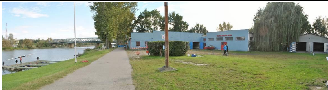
Az értékelt ingatlanról készített látkép, jobbra az 1-es, 2-es, 3-as épületek
