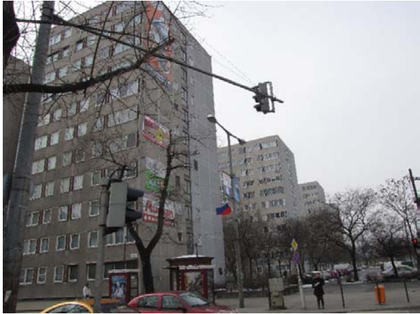
Ady Endre úti lakóépületek megújítása
