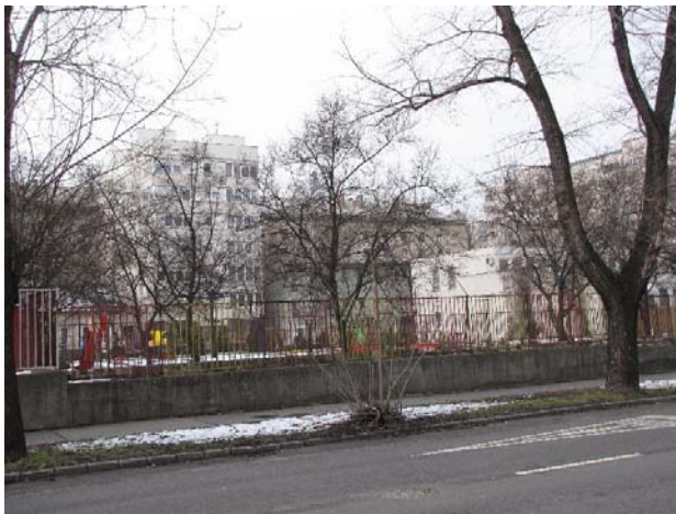
Többcélú sportlétesítmény építése
