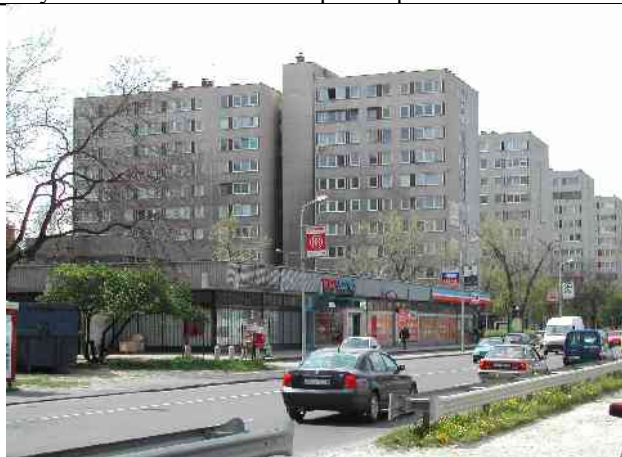
2-es tömb Ady Endre úti F + 10 szintes panel épületek
