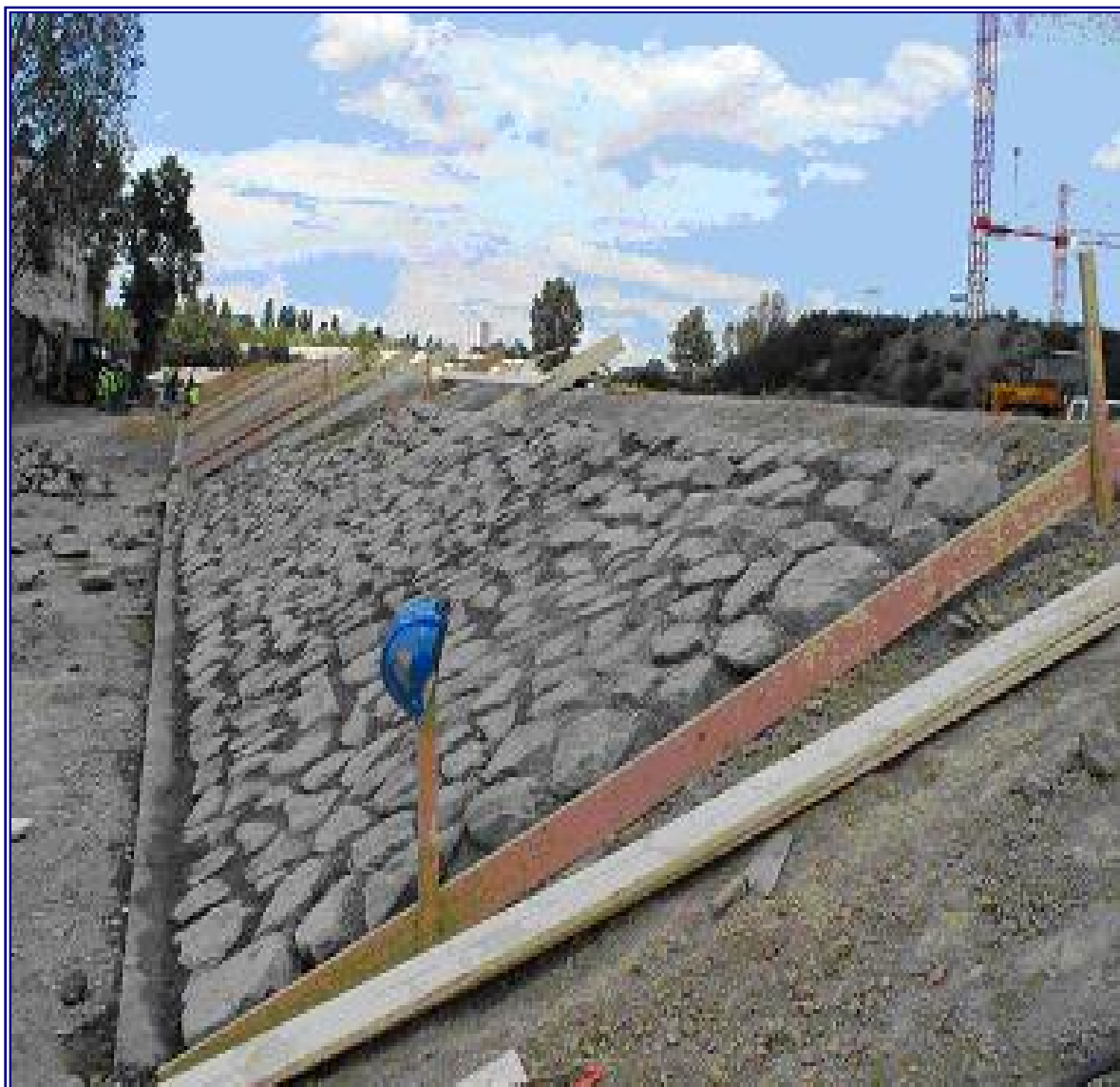
1. ábra Árvízvédelmi mú
